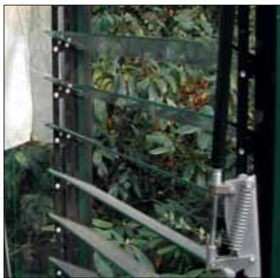
Lamellenfenster, schwarz für Seitenwand, mit ESG 4 mm
