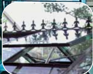
Dachfenster mit automatischen Fensteröffnern
